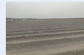
D 栋混凝土屋顶
