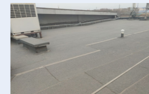
A/B 栋彩钢房屋顶
